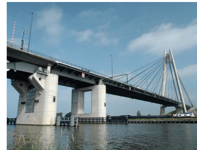
Pont basculant et pont suspendu
